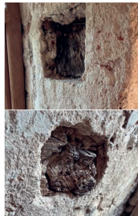
Ил. 41. Дубовые связи в стене, сложенной из плинфы (постройка XII века). На верхнем снимке видна деформация древесины. Фото Н.Л. Ребриковой
