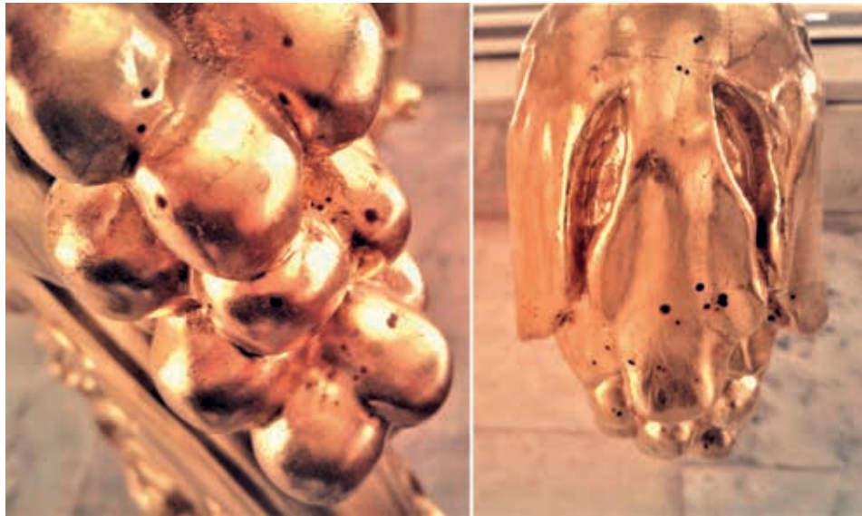
Ил. 61. Засиды мух на поверхности позолоченной деревянной резьбы. Фото автора
