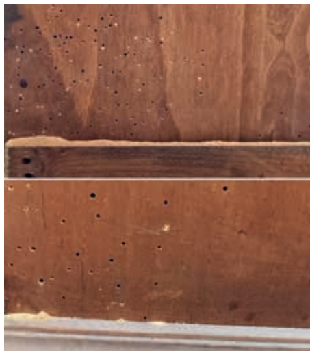
Ил. 32. Повреждение мебельным точильщиком музейного оборудования (задняя стенка и передняя поверхность шкафа): свежие летные отверстия, осыпи буровой муки. Фото автора
