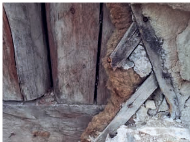
Ил. 73. Пример утепления исторической постройки из дерева (наружная сторона здания) первой половины XIX в.: толстый слой войлока, дранка, штукатурный слой. Фото автора
