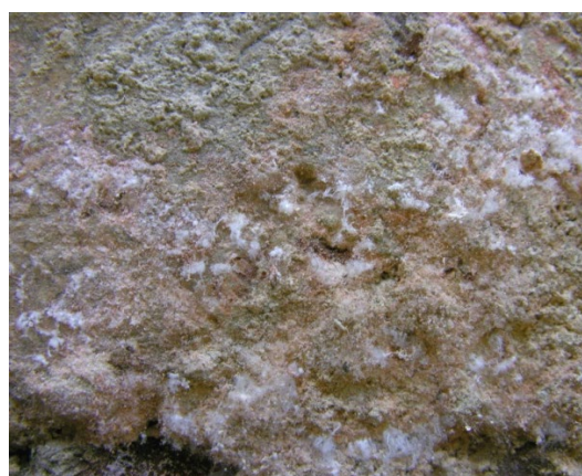
Рис.15. Спасо - Преображенский собор Спасо-Ефросиниевского монастыря: а) общий вид; б) стенопись собора, XII в.; в) обогреватель в непосредственной близости от стенописи; г) налеты водорастворимых солей на стенописи в дьяконнике
