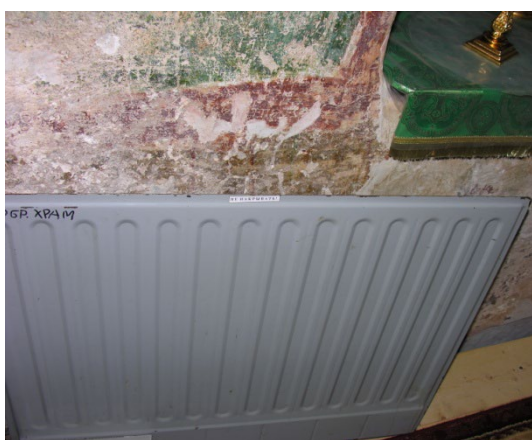
Рис.15. Спасо - Преображенский собор Спасо-Ефросиниевского монастыря: а) общий вид; б) стенопись собора, XII в.; в) обогреватель в непосредственной близости от стенописи; г) налеты водорастворимых солей на стенописи в дьяконнике
