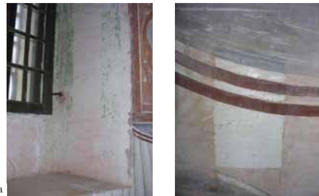
Ил. 55. Пробная расчистка а). Откос окна Никольского придела. Пробная расчистка; б). Южная стена четверика. Тестовый участок на стенописи
